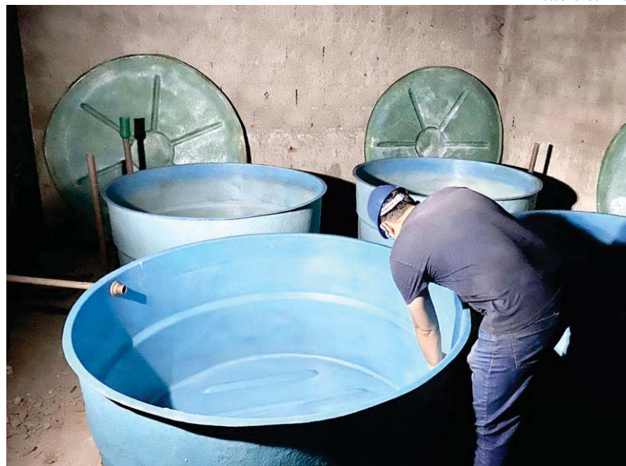
Após Fernando Linhares assumir a presidência da Câmara Municipal, foram realizadas as limpezas e dedetizações de todas as caixas
