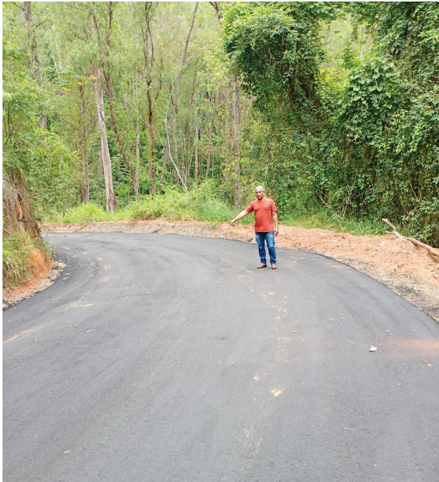
Na imagem, o vereador Zé Venut aparece na Rua Mato Grosso, na zona rural de Bela Vista de Minas, mostrando as melhorias realizadas com o asfaltamento da via, obra executada após solicitação do parlamentar e atendida pela prefeita Samantha Ávila.
