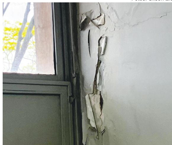
O Celeste esteve no local e encontrou parede molhada, manchas, reboco se soltando, forte cheiro de mofo e até pano enrolado para conter água dentro da sala
