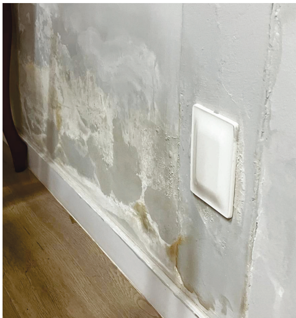
O Celeste esteve no local e encontrou parede molhada, manchas, reboco se soltando, forte cheiro de mofo e até pano enrolado para conter água dentro da sala
