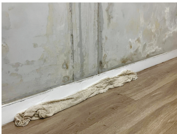
O Celeste esteve no local e encontrou parede molhada, manchas, reboco se soltando, forte cheiro de mofo e até pano enrolado para conter água dentro da sala
